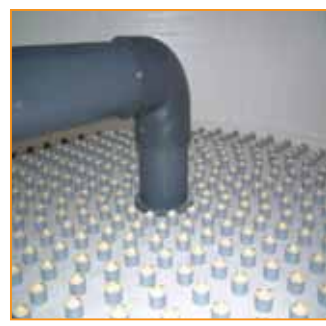
PLACA DE CREPINAS / NOZZLE PLATE PLANCHER DE CRÉPINES
